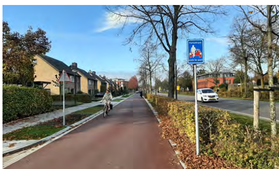
Fietsstraat Populierlaan (tijdens aanleg, november 2021)
